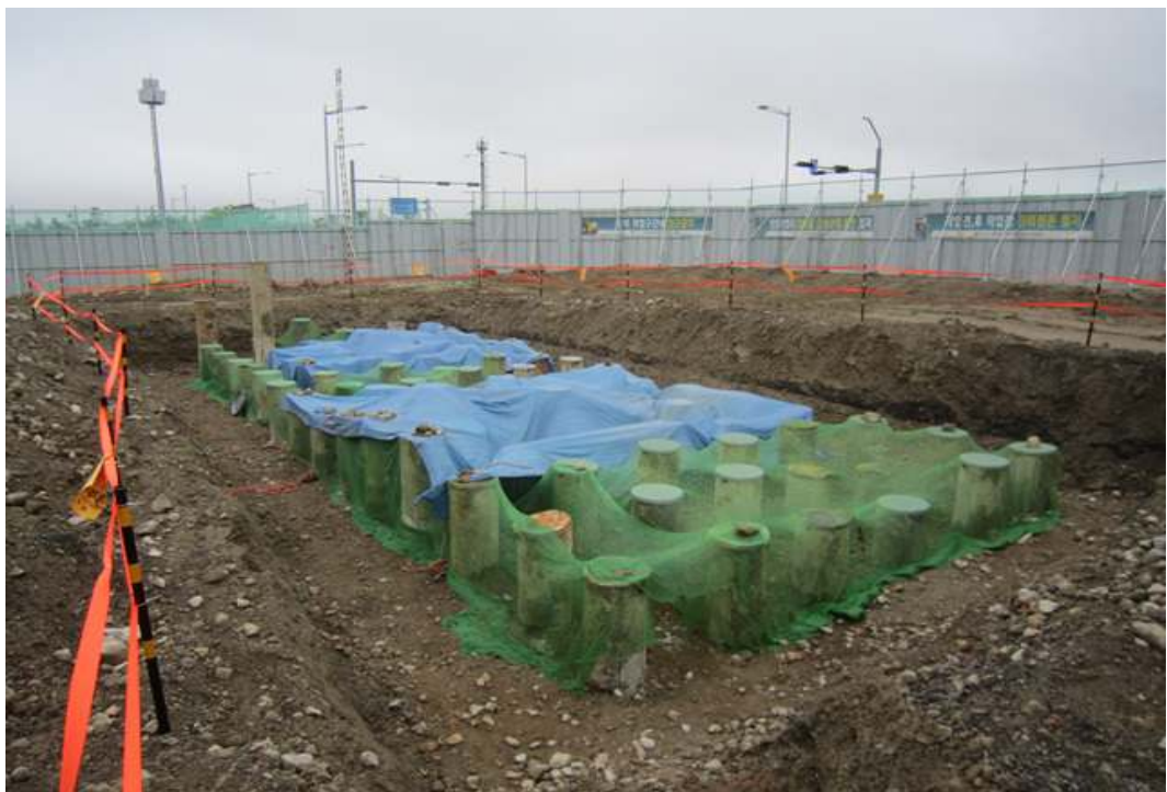
교량 교대 A2 말뚝기초 시공현황
