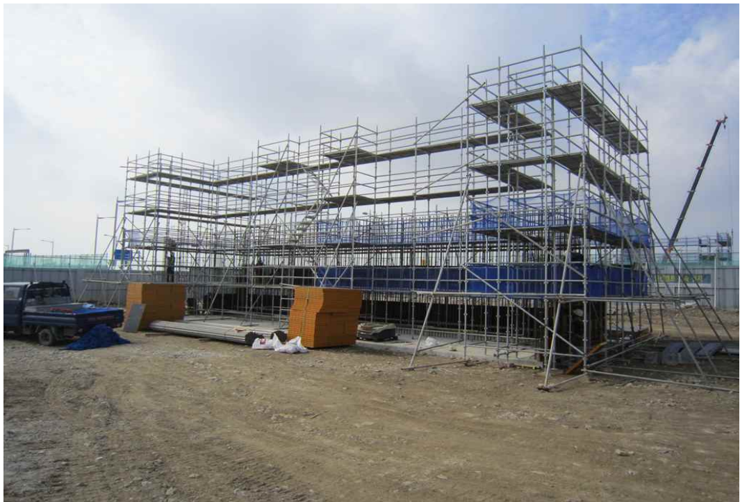
교량 교대 A2 동바리 및 거푸집 전경
