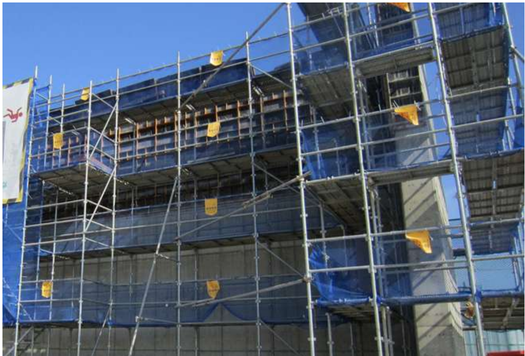
교량 교대 A1 동바리 및 거푸집 전경
