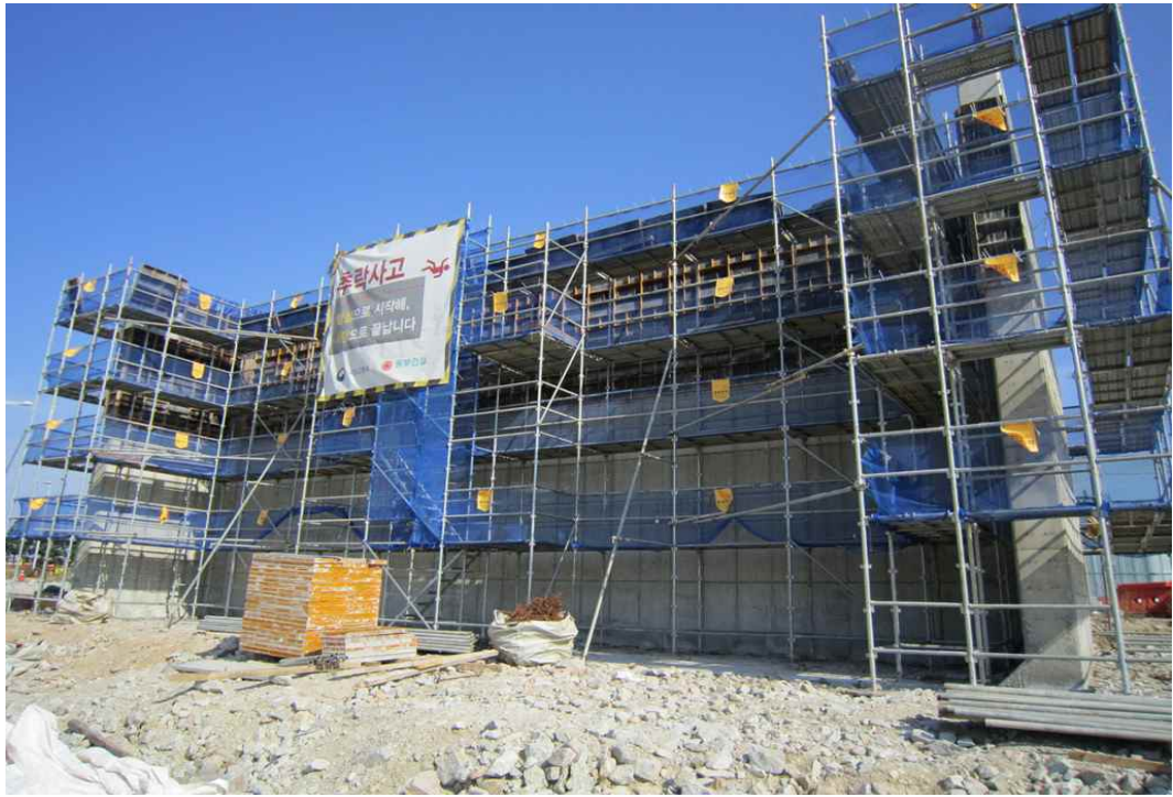
교량 교대 A1 동바리 및 거푸집 전경
