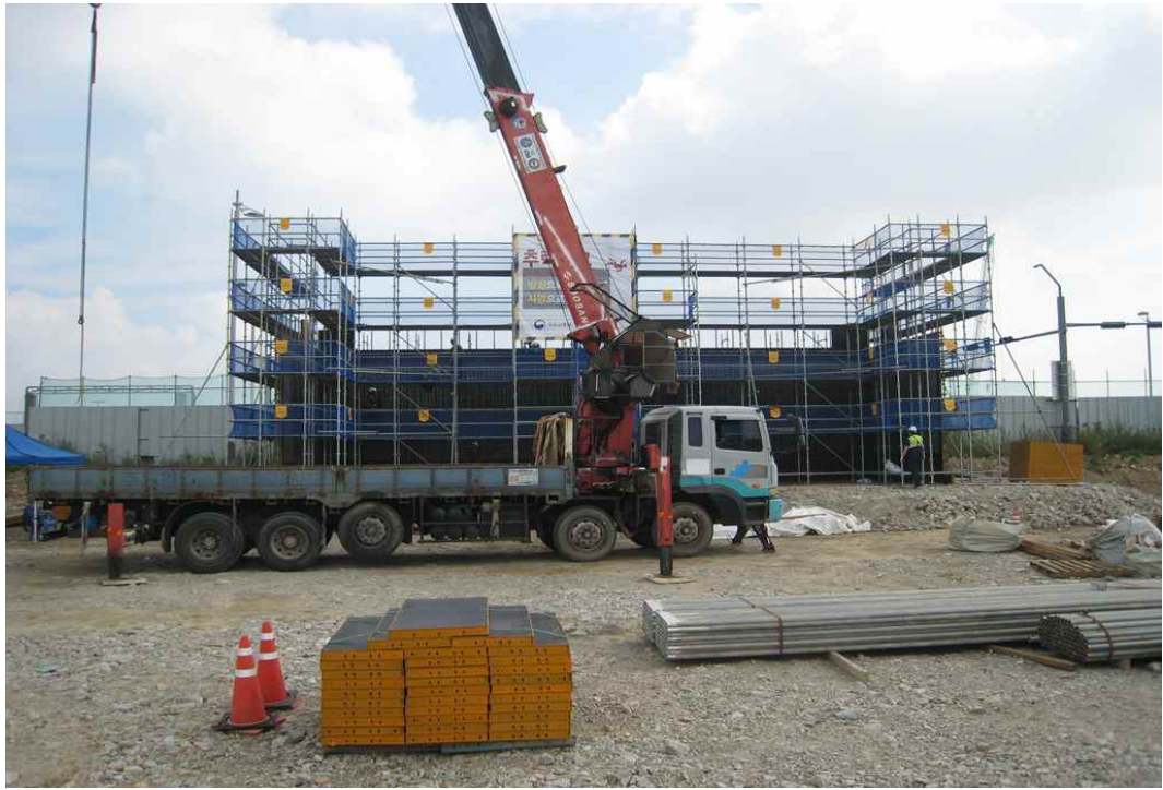
교량 교대 A1 동바리 및 거푸집 전경
