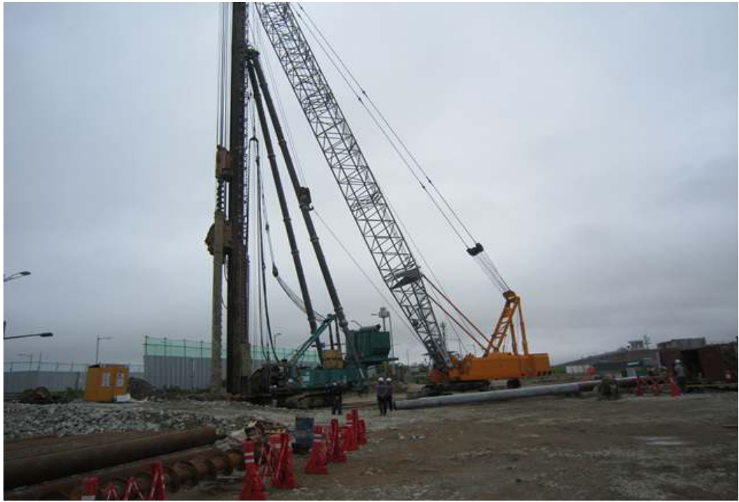
교량 교대 A1 시향타 전경
