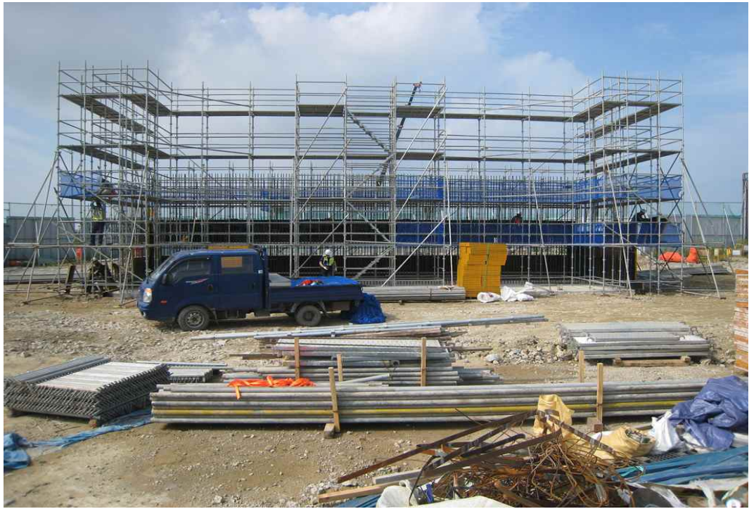
교량 교대 A2 동바리 및 거푸집 전경
