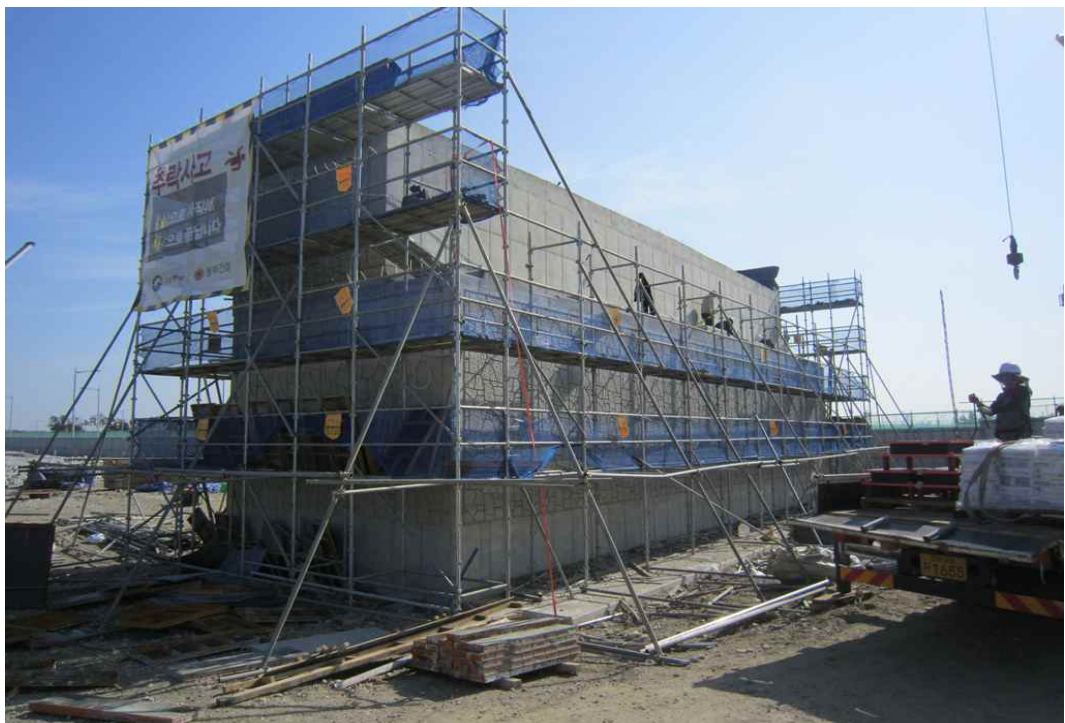
교량 교대 A2 동바리 및 거푸집 전경
