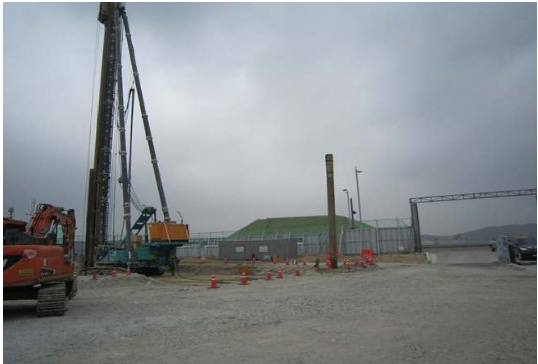
교량 교대 A2 시향타 전경
