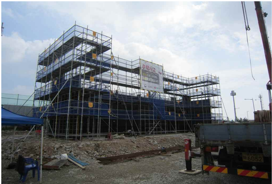
교량 교대 A1 동바리 및 거푸집 전경
