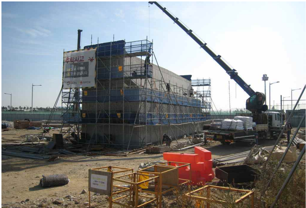
교량 교대 A2 동바리 및 거푸집 전경
