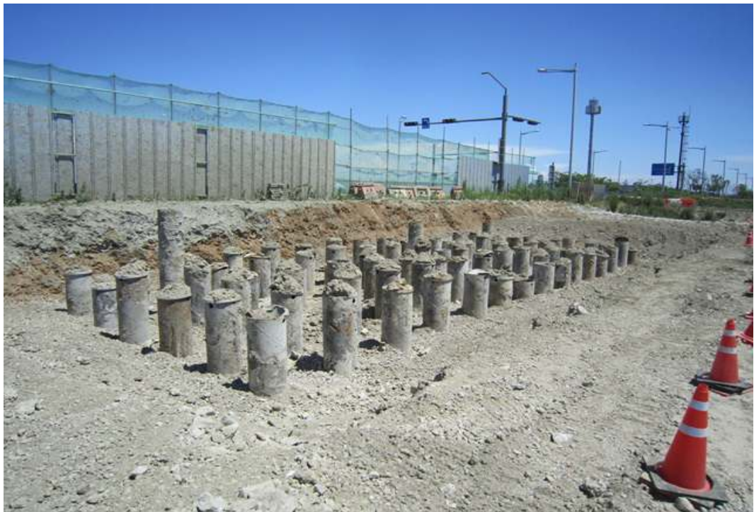
교량 교대 A1 말뚝기초 시공현황
